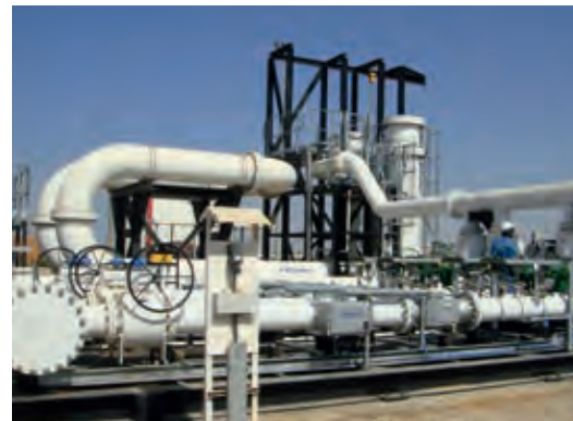
Sistema de medida montado en patín con probador bidireccional integrado
