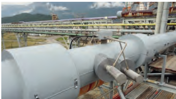
Medida de caudal ultrasónica de vapor recalentado
