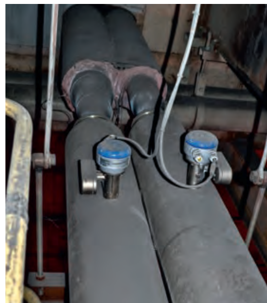
Medida de caudal másico de combustible pesado
