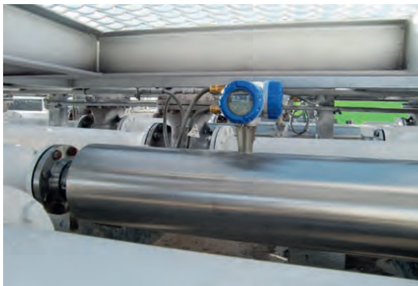
OPTIMASS 2000 - Mínimos requisitos de instalación
