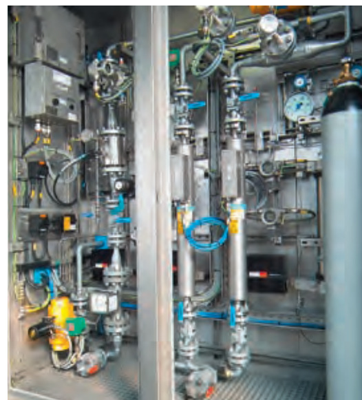
Cabina de analizadores para sistema de medida de líquidos
