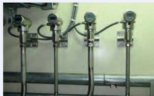
Medida de nivel TDR de condensados en entornos con radiaciones
