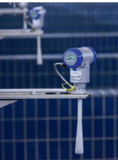
Medida de nivel en plantas depuradoras de agua
